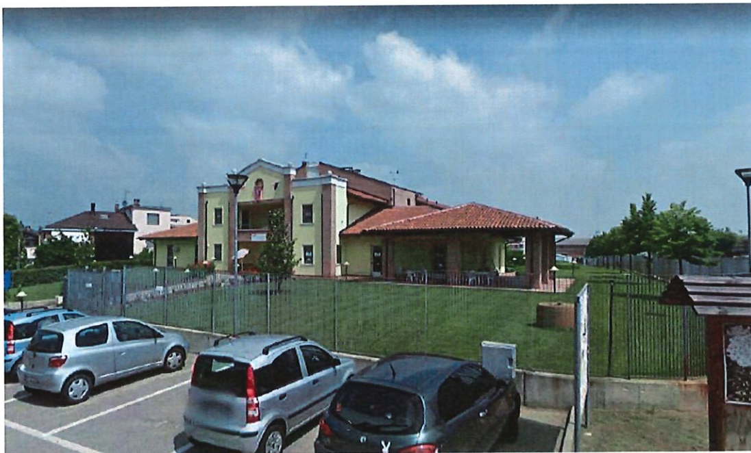
FOTO 2 – Vista prospetto principale
